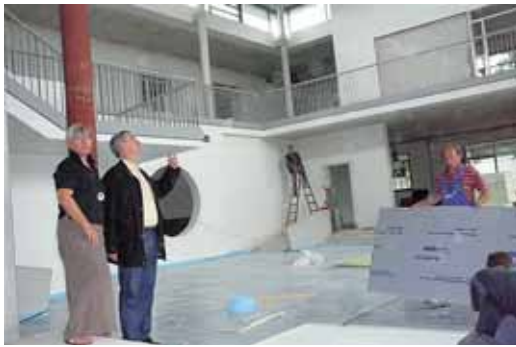
Hermann Schmid von der lokalen Presse und Ingrid Lanz besichtigen die Fortschritte auf der Baustelle.
