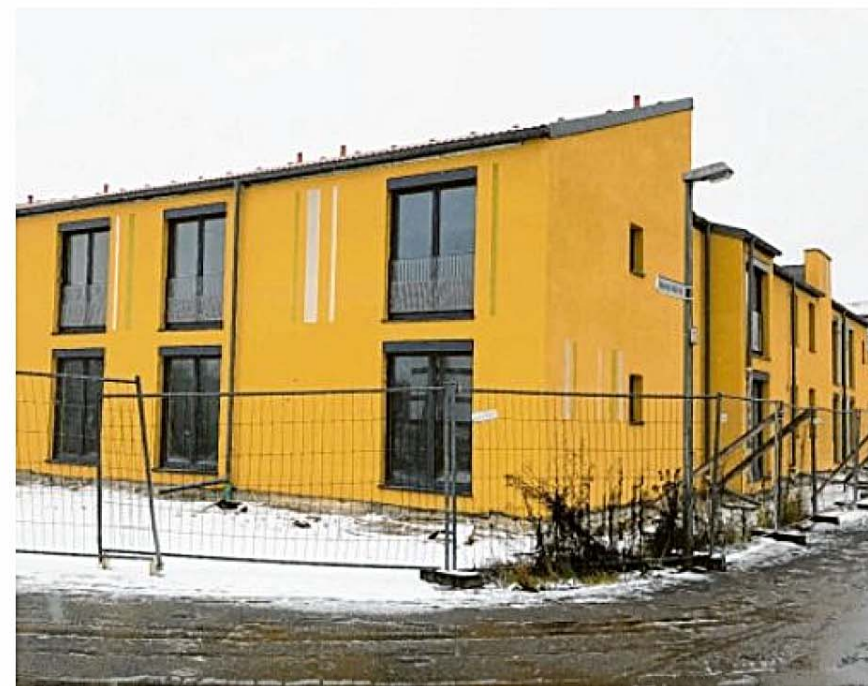
Die Lebenshilfe hat ein neues Wohnheim für behinderte Menschen im Gögginger Neubaugebiet „Südlich der Friedrich-Ebert-Straße“ gebaut. Foto: Fridtjof Atterdal
